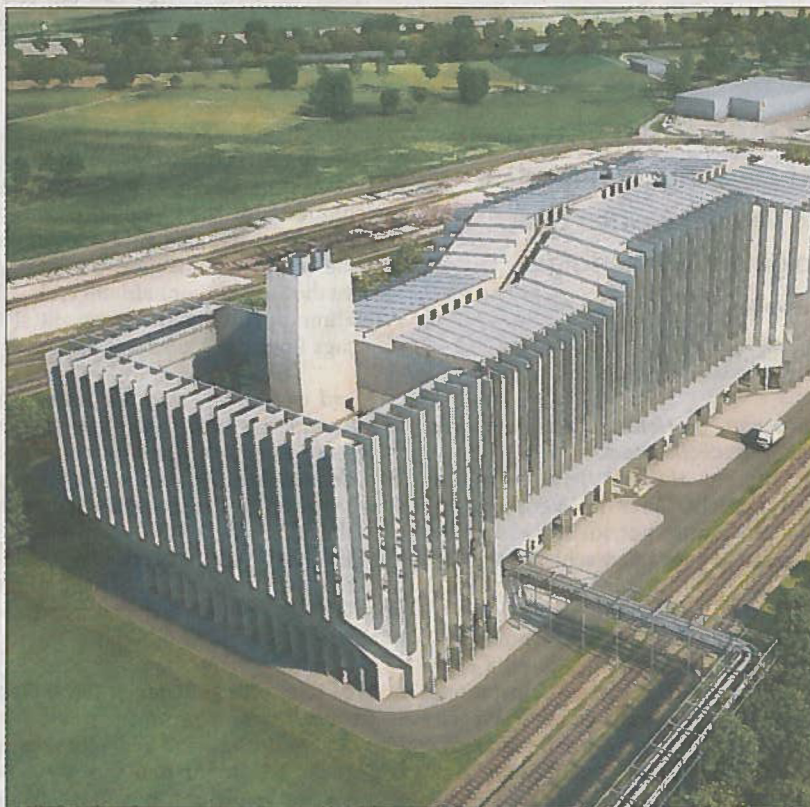
Oben: Der «Spatenstich» erfolgt mit einer Pfählmachine. Unten: So soll die Renergia dereinst aussehen.
